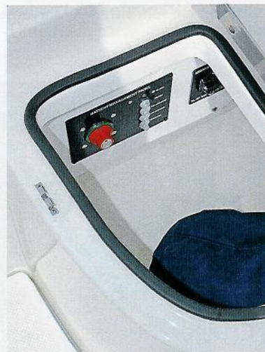
Der Batterie Hauptschalter wurde unter dem Cockpitsitz befestigt
